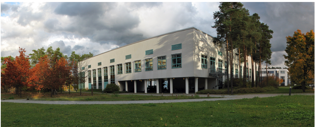
Abb. 9.1: Gebäude des Lehrstuhls für Elektronische Bauelemente, Cauerstraße 6. Blick von der Cauerstraße. Vollständiger Lageplan zur Technischen Fakultät auf der nächsten Seite
